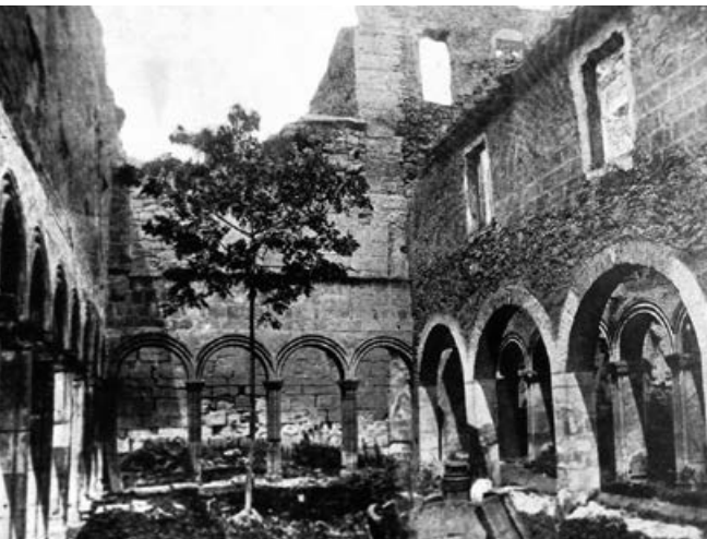
El claustre de Sant Esteve abans de la restauració.
