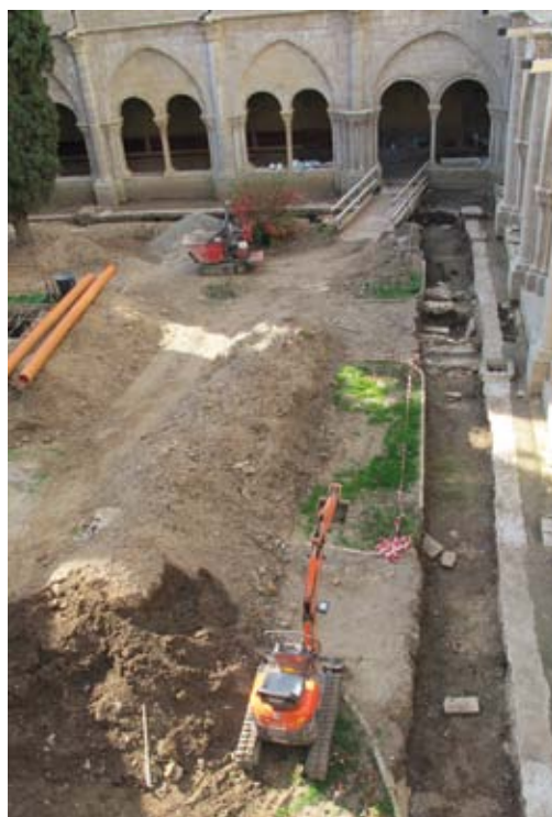
Obres realitzades al perímetre intern del claustre
