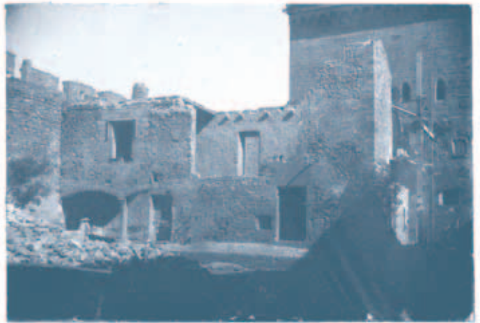
Els treballs de reconstrucció l'any 1932.
