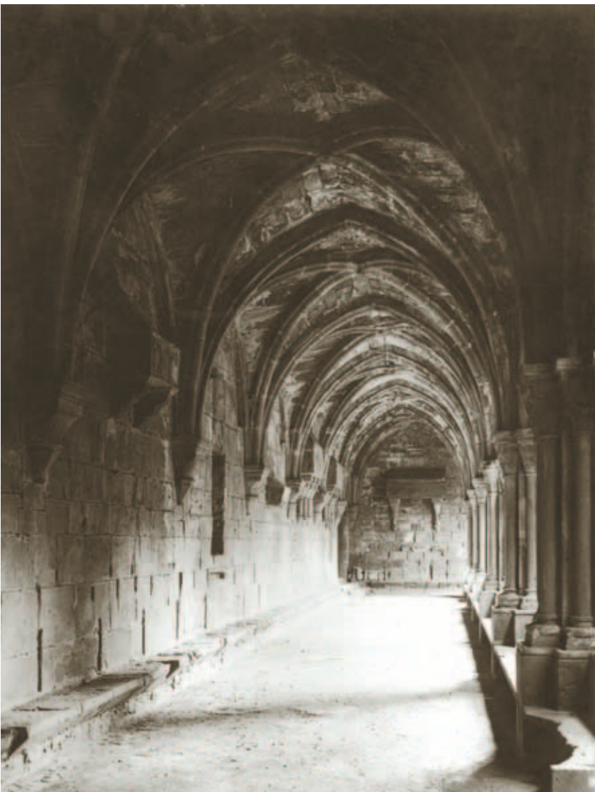
El claustre de Poblet, abans de la restauració.
