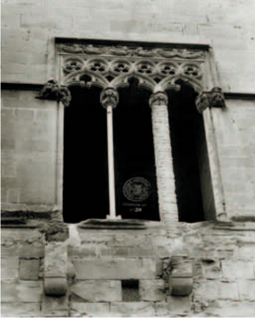
Finestra coronela amb el fust d'una de les columnes substituït per un pilar d'obra vista.
