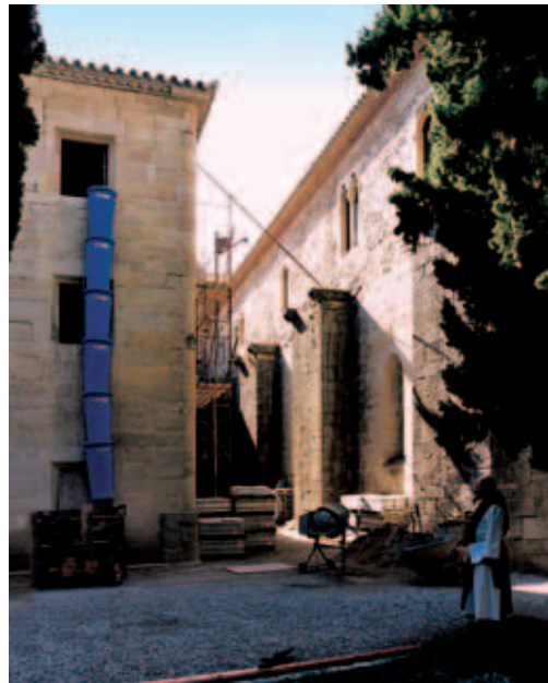
Obres de restauració actual a la Casa dels Germans
